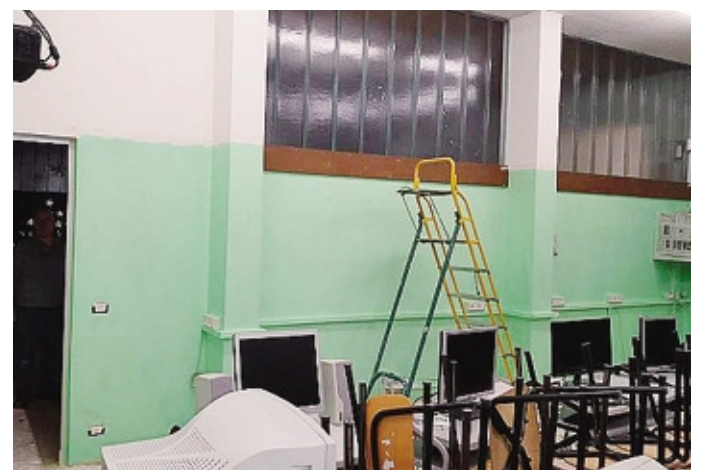
Un'immagine del cantiere dei volontari nell'aula di informatica
