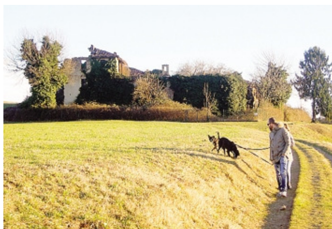
Santa Naga: la struttura è sempre più degradata FOTO BARTESAGHI
