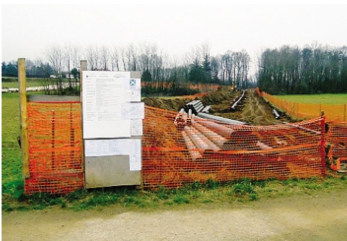
Via ai lavori per il metanodotto Snam BARTESAGHU
