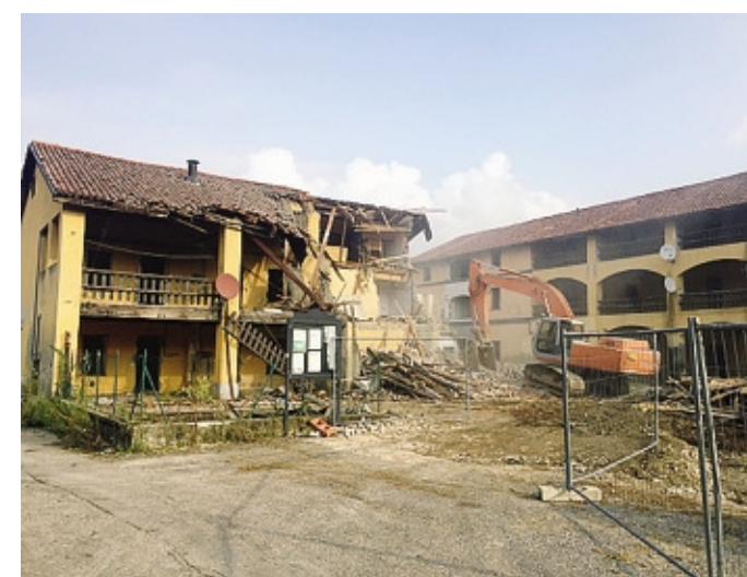
La demolizione dell'antica cascina, che ospitava le case popolari
